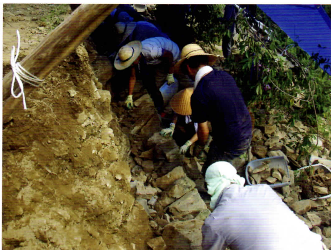
「坂折棚田の空石積みの作業の様子」(提供：金子玲大)
