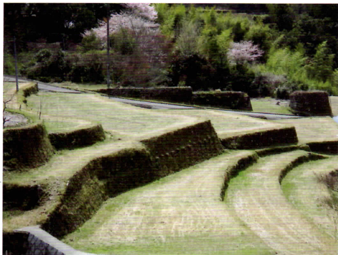
「石積の足場工法」(三重県熊野市紀和町) 長い石が等間隔で石積みから飛び出している足場工法は、 除草など高い石積みの管理用の足場として作られている。 (提供：岡島賢治)
